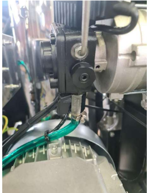
Válvula de bola de seccionamiento de gasóleo
